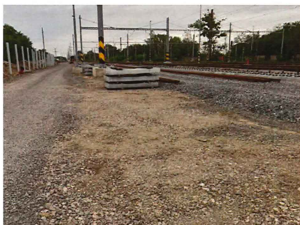
02-32-01, 02, Sypanie kameňa a kladenie podvalov
