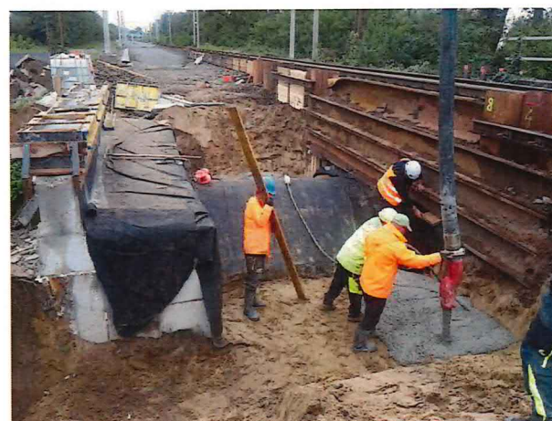
01-33-03, Armovanie, debnenie a betonáž rímsoy, prechodové oblasti
