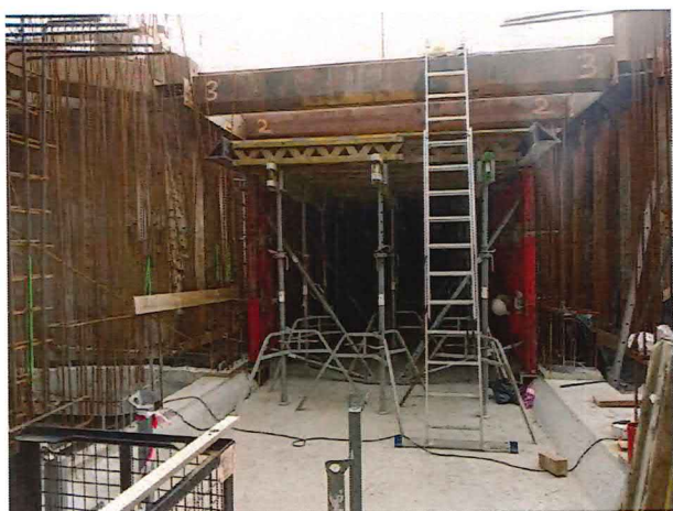
02-33-01, Armovanie a debnenie stropu a podkladovej dosky schodísk
