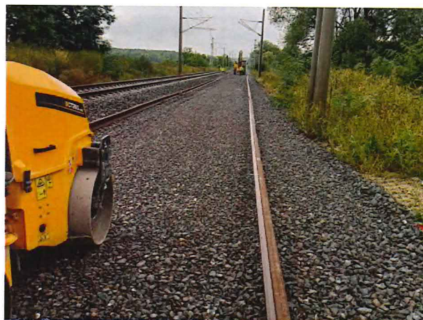
11-32-02, Hutnenie koľajového kameňa
