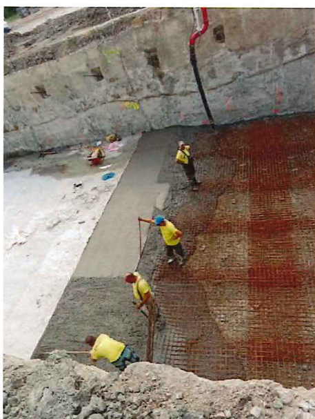
11-33-06, Betonáž podkladovej dosky a výkopy
