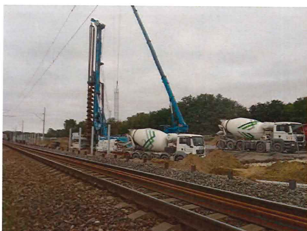
01-33-06, Realizácia pilót, odkopy a hutnenie lôžka pre základ
