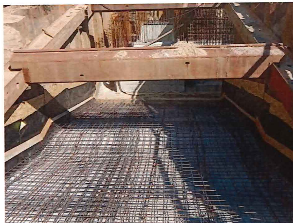
02-33-01, Armovanie a debnenie stropu a podkladovej dosky schodísk
