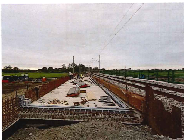
12-33-02, Montáž mostných záverov
