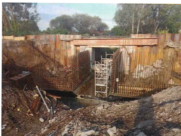
01-33-16, Armovanie debnenie a betonáž opôr
