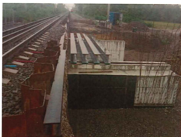
01-33-12, Ukladanie oceľových nosníkov mostovky
