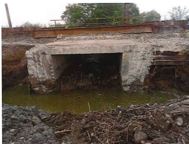
01-33-15, Čerpanie vody a armovanie rozšírenia opôr
