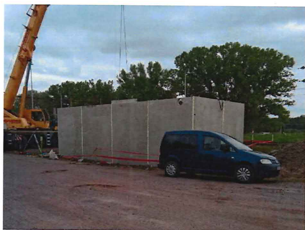
10-34-10, Montáž prefa, technologický objekt
