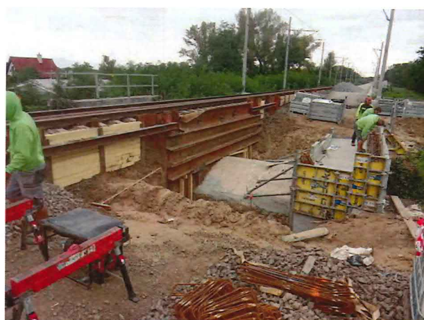
01-33-03, Armovanie a debnenie rím, hydroizolácia
