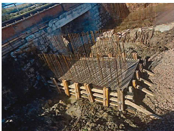
01-33-12, Armovanie, debnenie a betonáž základov, čerpanie vody
