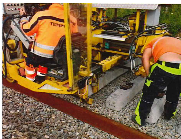
11-32-02, Hutnenie koľajového kameňa
