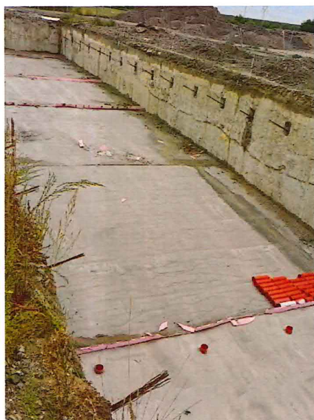
11-33-06, Podkladový betón, podjazd
