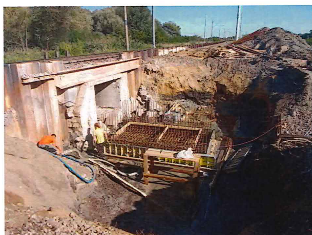
01-33-16, Armovanie, debnenie a betonáž základov
