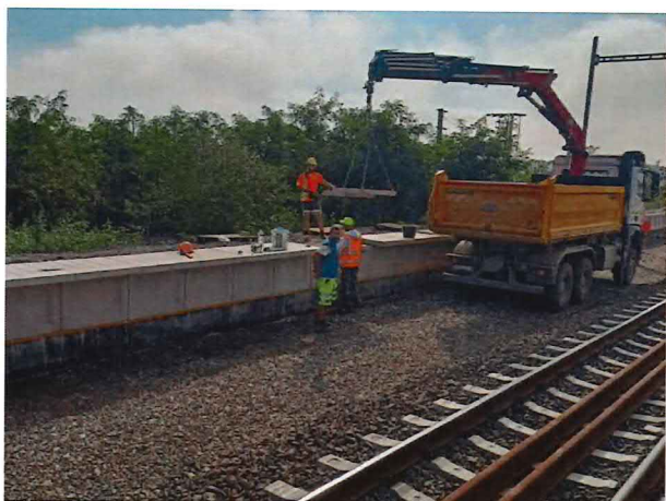
11-32-04, Montáž konzolových dosiek
